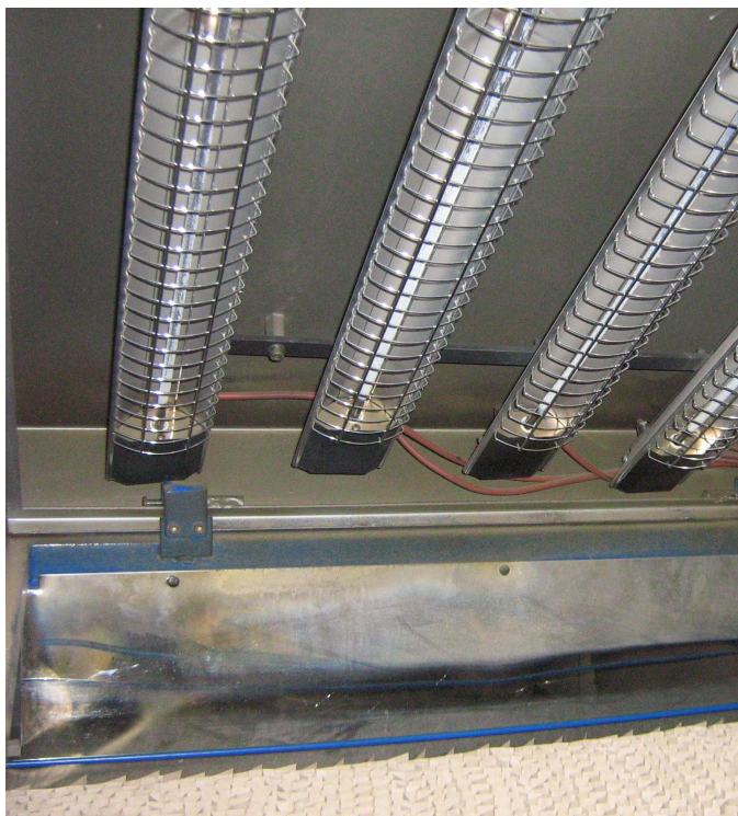
Rysunek 4. Widok grzałek w maszynie już pracującej.
